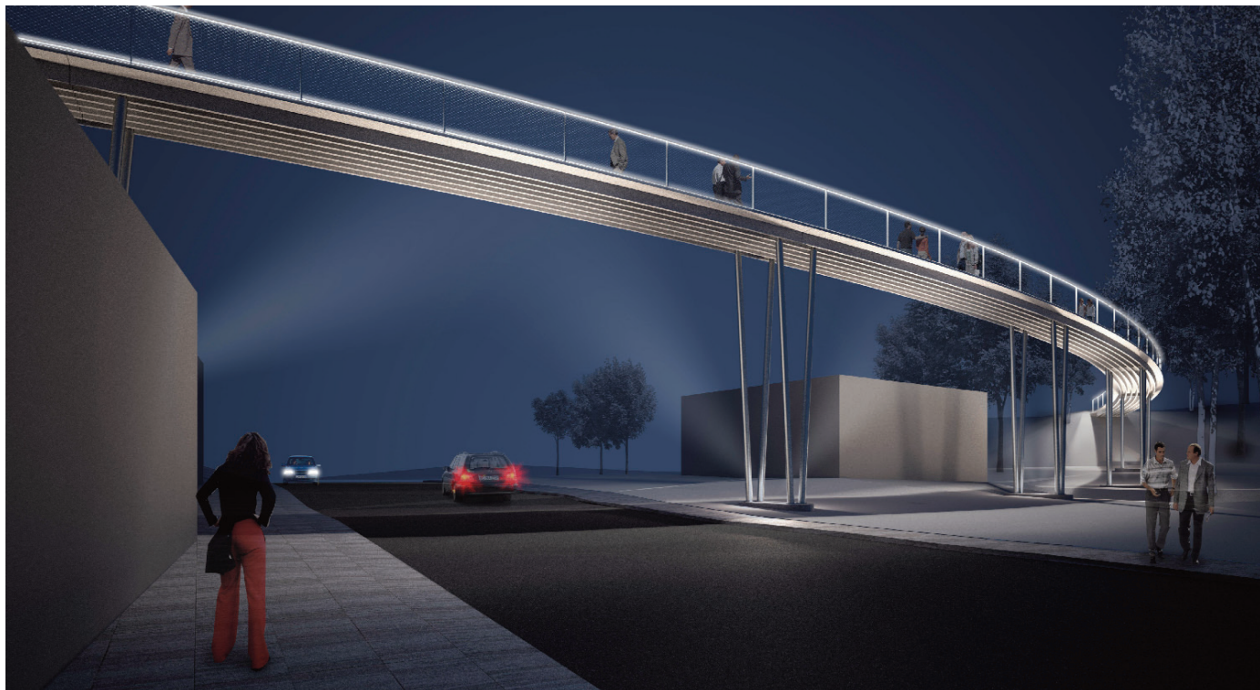
Blickfang bei Tag und in der Nacht: Wenn's dunkel wird, erhellen integrierte LED-Lichter die Brücke. Die aus einer Textilbeton-Laufplatte und einer Metallkonstruktion mit Edelstahlgeländer bestehende Brücke ist insgesamt 100 Meter lang. Bild: TU Aachen, Prof. Hegger, Prof. Schneider
