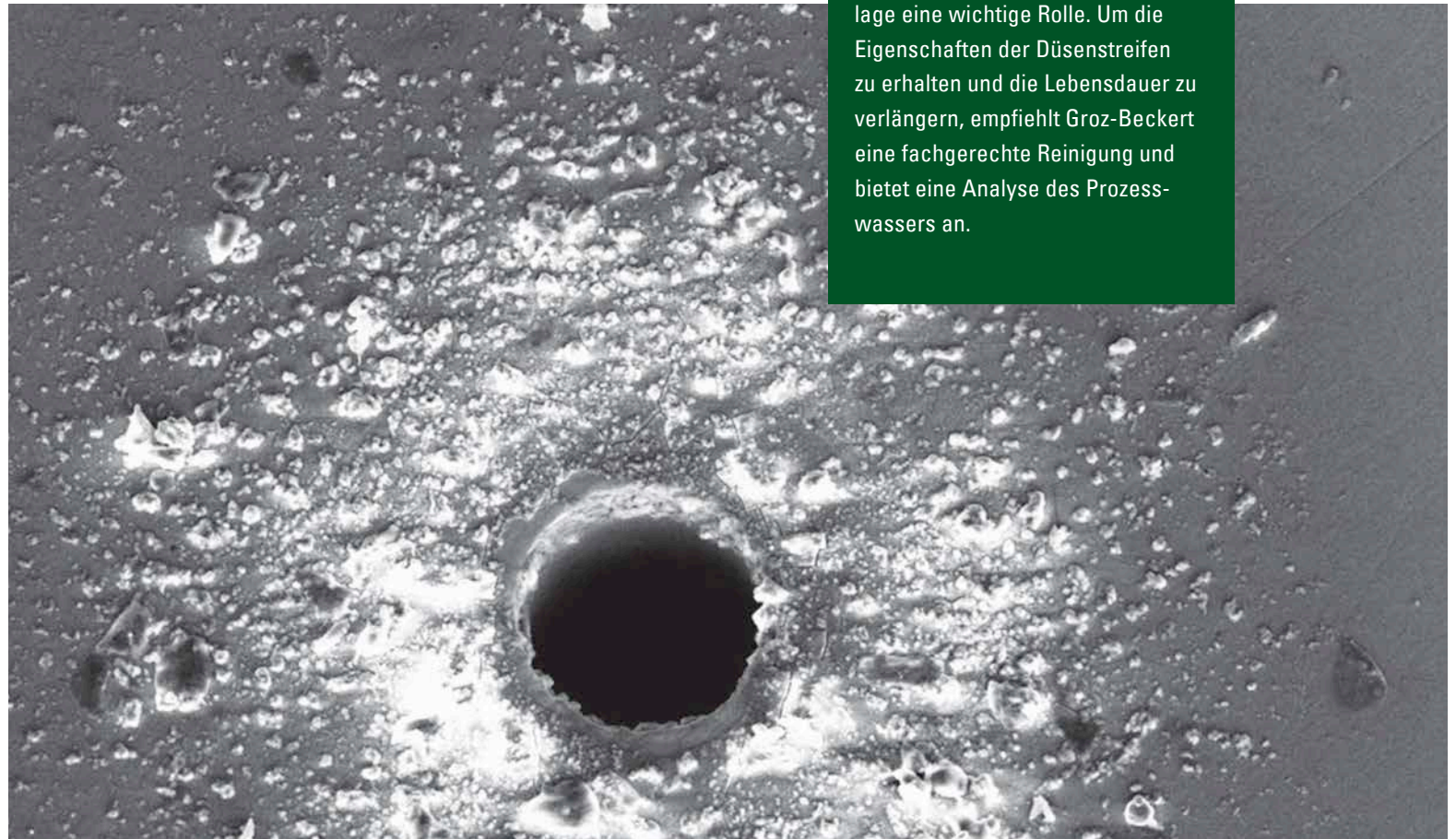
Kalkablagerung im Bereich der Düse
