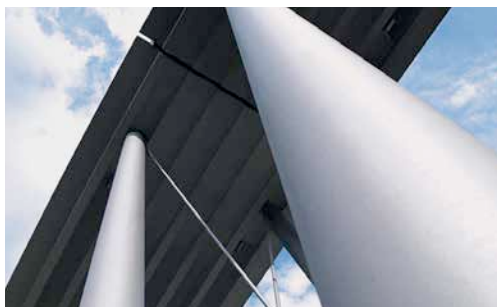
Brückenbau mit textilen Bewehrungen
