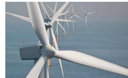
Einsatz von Faserverbundstoffen im Leichtbau
