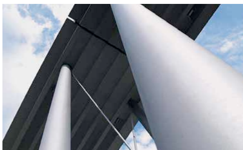
Brückenbau mit textilen Bewehrungen
